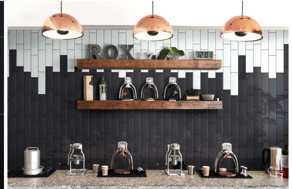
Aplicación tipo ladrillo vertical con desplazamiento al 50%, colores de contraste y terminación irregular.
