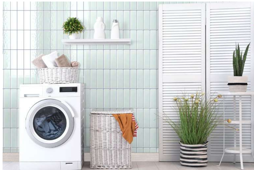
Aplicación continua vertical con junta de 2 mm.
